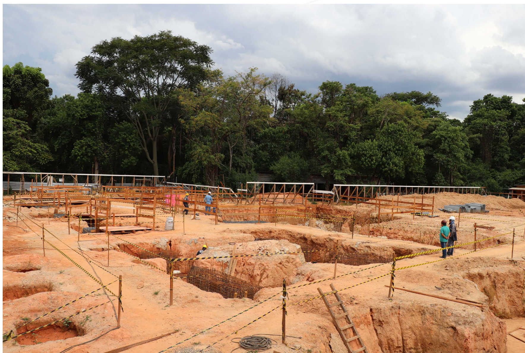
Construção do CN Vacinas no Parque Tecnológico de Belo Horizonte (BH-TEC)
