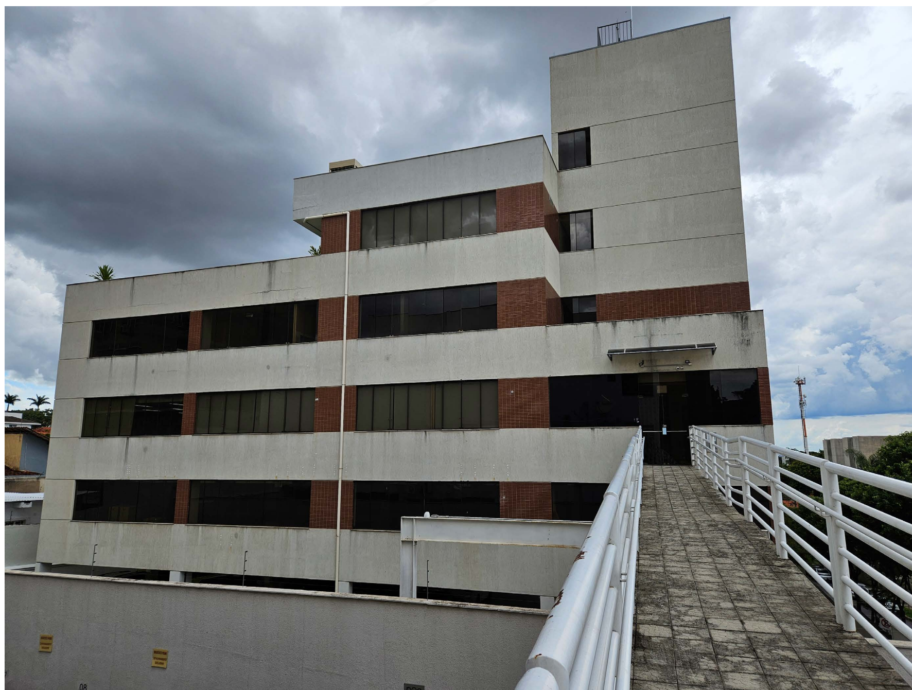
Fachada do prédio Fabiano Cançado
